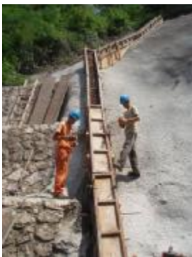
Slika 10. Stabilizaciona AB greda Figure 10. RC stabilization beam
