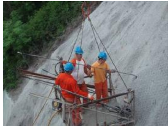
Slika 9. Ugradnja štapnih sidara Figure 9. Installing anchors piston
