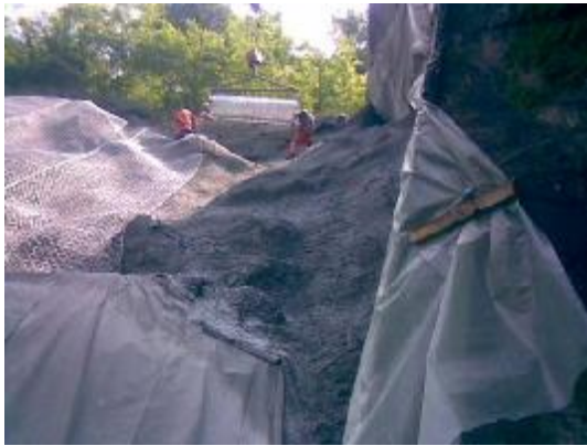
Slika 8. Ugradnja heksagonalne pletene pocinčane čelične mreže Figure 8. Installation of hexagonal woven galvanized steel net
