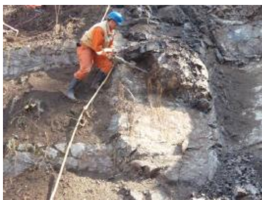
Slika 5. Čišćenje oslabljenih blokova stene Figure 5. Cleaning the weakened wall blocks
