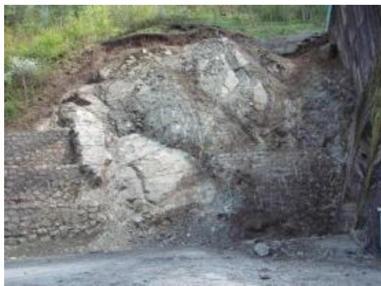
Slika 6. Pripremljena podloga Figure 6. Prepared construction base
