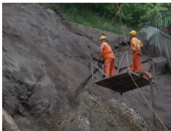
Slika 7. Nanošenje kontaktnog sloja mlaznog betona Figure 7. Application of contact layer sprayed concrete
