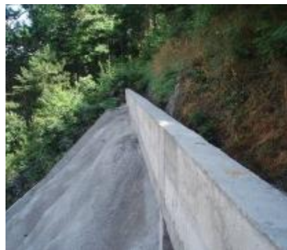
Slika 11. Zaštitna AB greda a) izvedeno stanje b) poprečni presek Figure 11. Protective RC beam a) final state b) cross section
