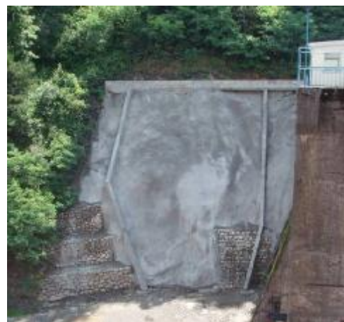
Slika 15. Stabilizacija padine (izgled) Figure 15. Slope stabilization (outlook)
